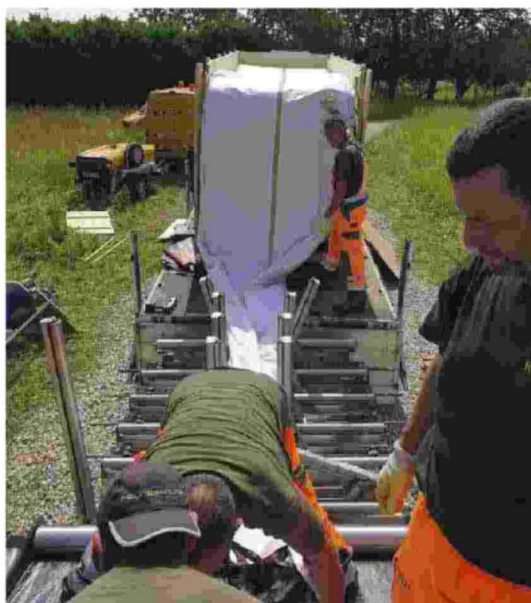
Nella zona fra via allo Stadio e via Papini i lavori preliminari al lancio della guaina che riveste i tubi del collettore fognario a sud della città
