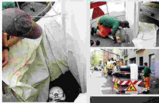
Sopra, il cantiere di via Bottego-Sabatelli; qui a destra, gli stessi tubi usati a Berlino; sotto, la "calza" che stanno mettendo all'interno dei tubi
