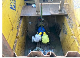
Saubere Sache: Trinkwasserleitung saniert
