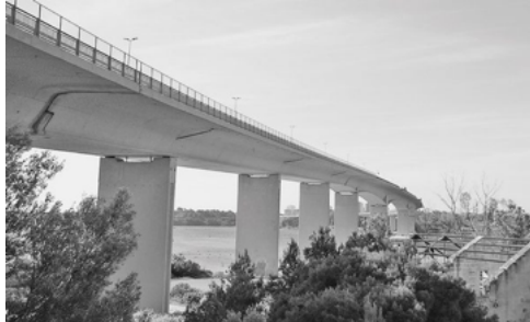
Die 1977 errichtete "Ponte Punta Penna Pizzone di Taranto" gilt als eine der längsten Spannbetonbrücke Europas.
