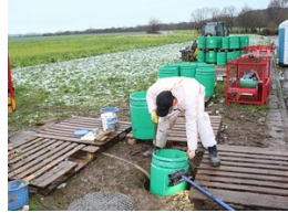
In Form gebracht: Sanierung mit Kurzrohr-Modulen durchgeführt
