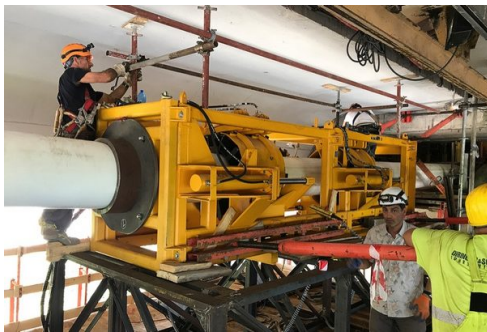
Das Gesenk mit zwei Pushern wurde in Höhe der sanierenden Leitung auf einem Arbeitspodest installiert und gegen den Brückenkörper verspannt.
