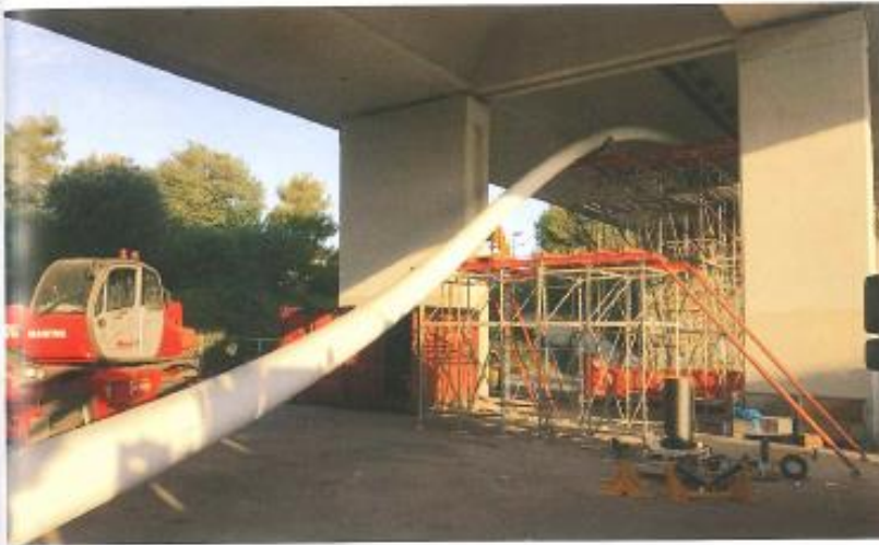
Zwischenpodeste mit Rollenblöcken zum Anheben des Rohrstrangs auf Höhe des Rig-Arbeitspodestes
