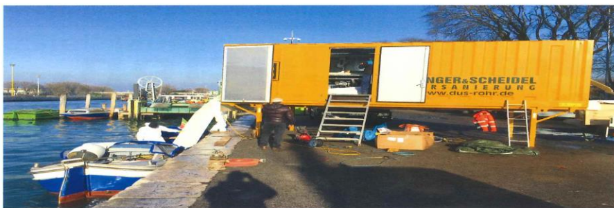
Der modulare Aufbau ist eine Trumpfkarte, die das BlueLine-Verfahren in Venedig voll ausspielen konnte. Hier: das mobile Tränkungswerk an der Kaimauer.
